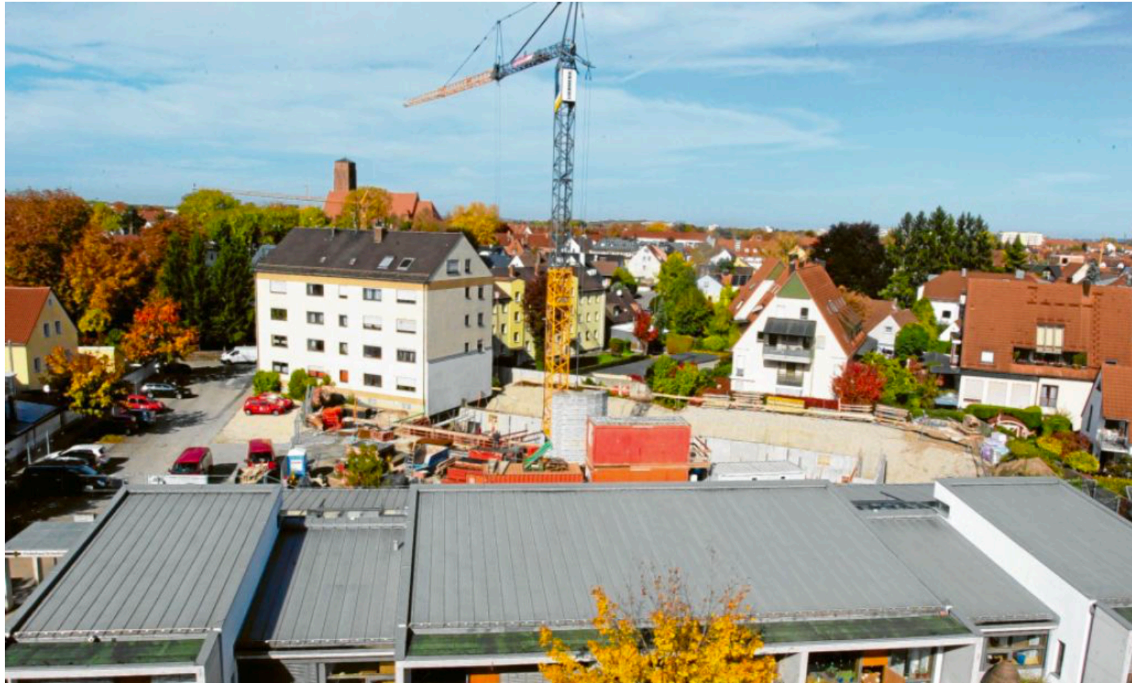
Im Lechhauser Zentrum entsteht eine neue Wohnanlage mit geförderten Wohnungen.
