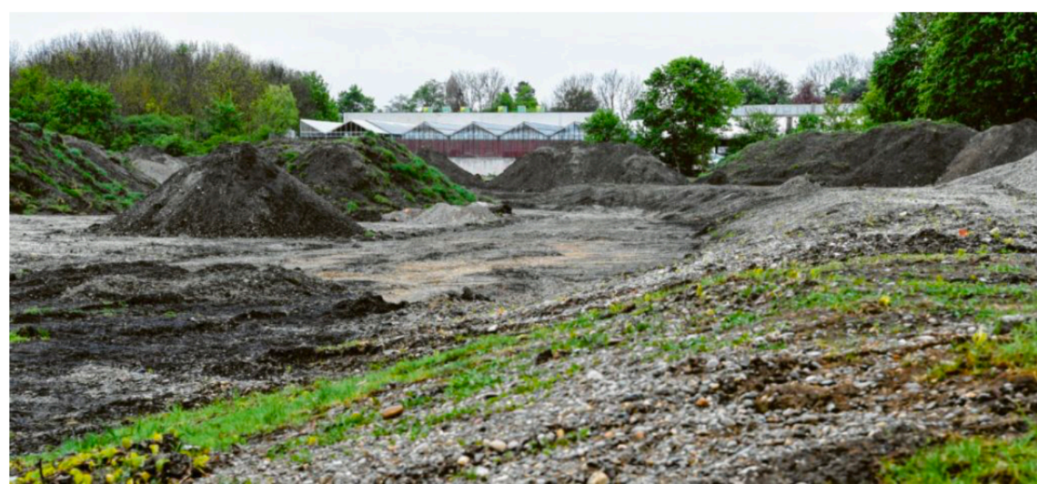
Das Dehner-Areal und das ehemalige Gelände des Post-SV an der Bürgermeister-Ackermann-Straße werden neu überplant. Das Garten-Center (hier im Hintergrund die Gewächshäuser) wird abgerissen und leicht versetzt neu aufgebaut. Auf dem 7,7 Hektar großen Areal entstehen 500 Wohnungen. Foto: Silvio Wyszengrad
